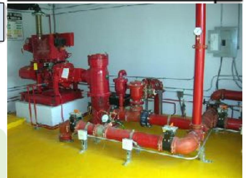
LOS ACCESORIOS DISEÑADOS PARA SISTEMAS CONTRA INCENDIO TRABAJAN A NO MAS DE 175psi, SI LA PRESION DE LA BOMBA EXEDE ESE LIMITE, TENDRA QUE INSTALARSE RISER (o Risers) DE ALTA Y BAJA PRESION DE ACUERDO AL ANALISIS POR NIVEL DEL EDIFICIO, RESULTANTE DEL CALCULO HIDRAULICO.
