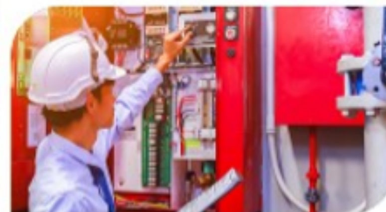
Ejecución y comisionamiento
